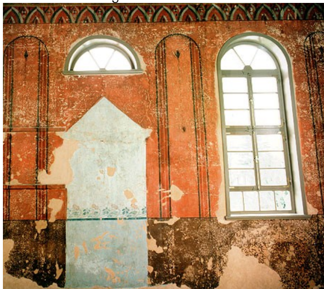
Landsynagoge Roth an der Lahn – Innenraum mit der Kontur des zerstörten Thoraschreins
