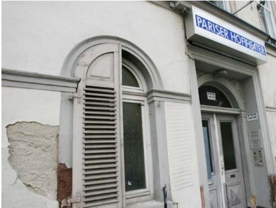
Pariser Hoftheater vor der Sanierung (Bild: FR/Surrey)
