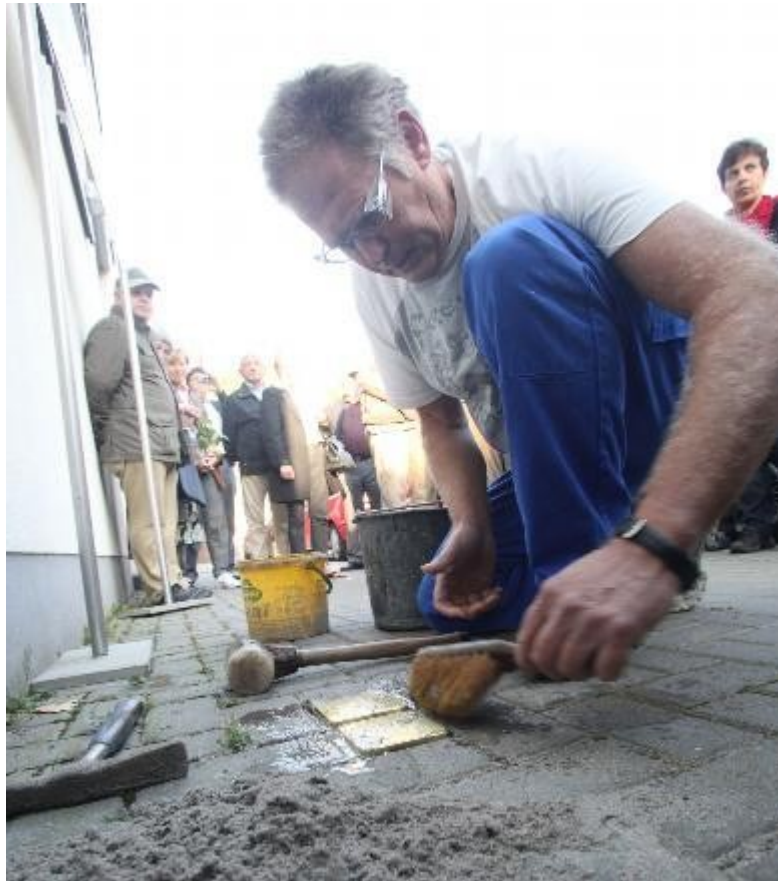
Verlegt die Stolpersteine für Mina und Moritz Marx: Jürgen Ranft vom Tiefbauamt. Foto: RMB/Kubenska
