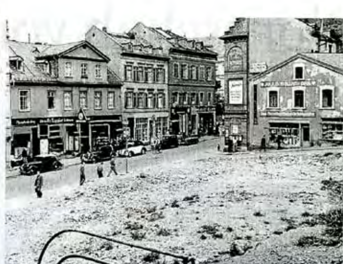
1950 nach dem Sockelabriss.
