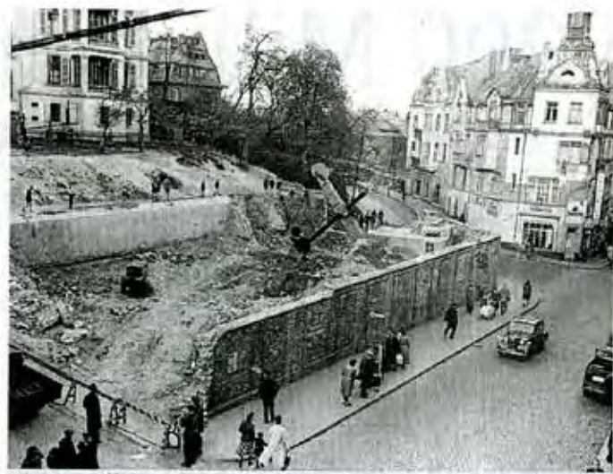
Der Synagogensockel vor dem Abriss 1950. Fotos: Stadtarchiv/Rudolph
