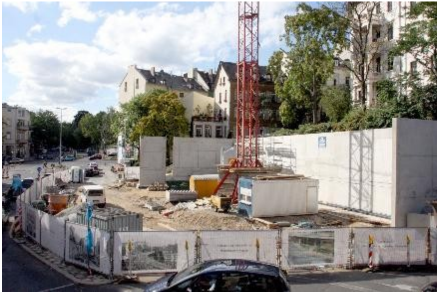
Rohbauarbeiten kurz vor dem Abschluss: Die Gedenkstätte am Michelsberg nimmt Form an. Foto: RMB/Kubenska
