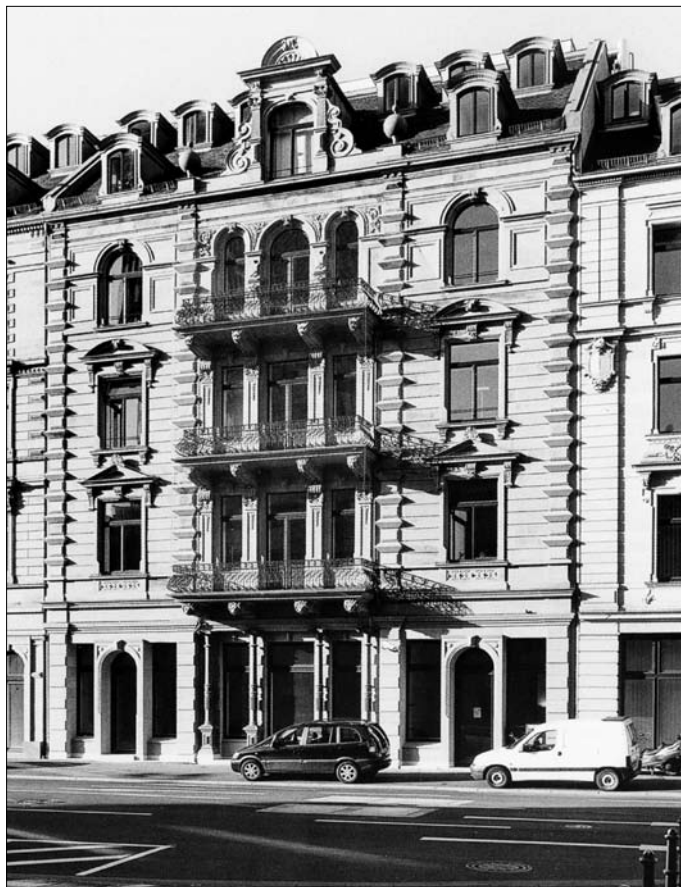
Taunusstraße 6 ehemaliges Wohn- und Praxishaus des Orthopäden Dr. med. Alfred Amson und seiner Familie Foto: Christine Krienke, Hessisches Landesamt f. Denkmalpflege
