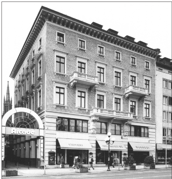
Wiesbaden, Wilhelmstraße 38, ehemaliges Bankhaus Berlé
