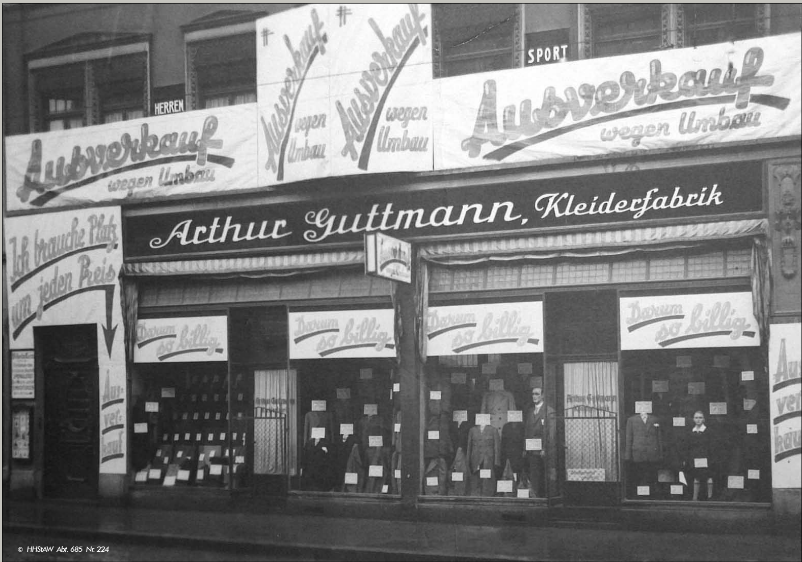
Fensterfront des Geschäftes, Große Bleiche 7 in Mainz, vor dem Umbau 1931
