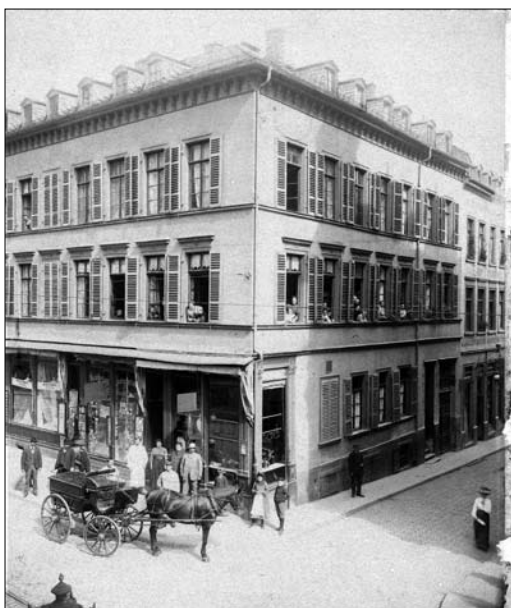
Haus Schulgasse/Ecke Kirchgasse ca. 1900 Foto: © Stadtarchiv Wiesbaden
