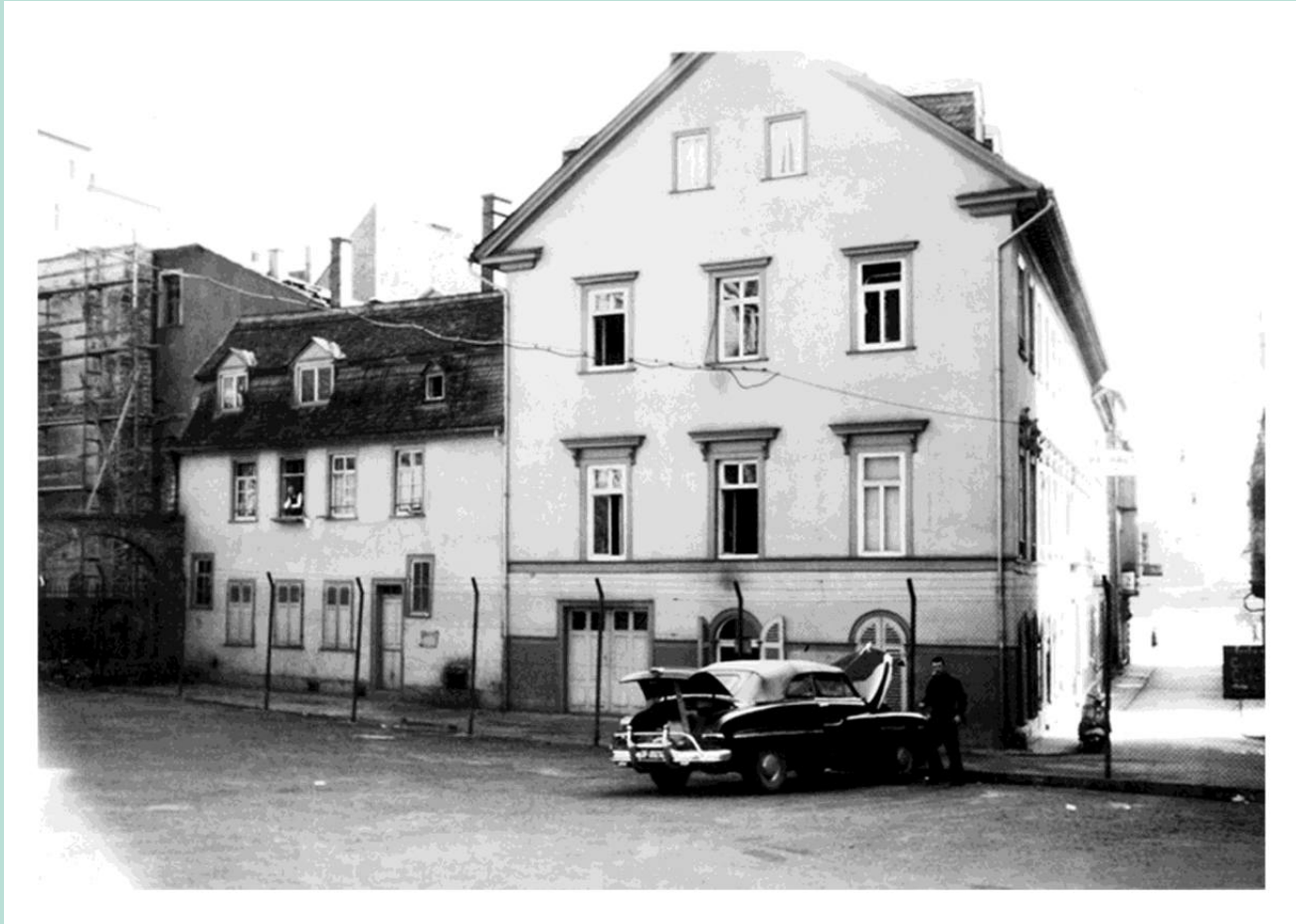
Blick auf das eingezäunte Haus Spiegelgasse 11 Willi Rudolph; Quelle: Stadtarchiv Wiesbaden
